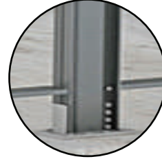
5. Alın Kolon ve Ankraj detayı
